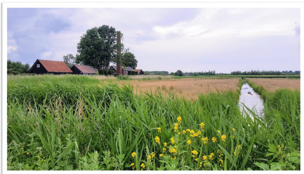
Stoomgemaal te Putten. (foto 16 juni 2020, Martin van Ee)
